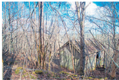
FØR OPPSTART: Slik så det ut i Melaaslia i april 2014, før arbeidet med plassen startet. Foto: Privat
