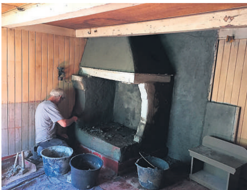
JULI 2017: Eystein Greibrokk i arbeid med leirepussen. Finpuss og maling tok paret seg av selv. Foto: Privat
