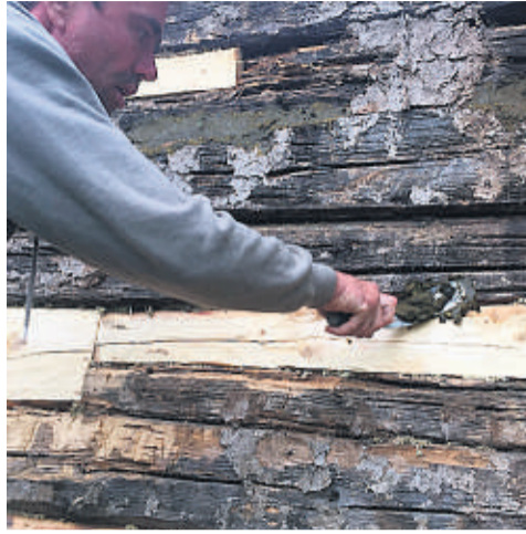
VARME AV KUMØKK: Arvid Sollie fra Sollie Bygg smører på ny diffusjonsåpen isolering (les: kumøkk). Foto: Privat
