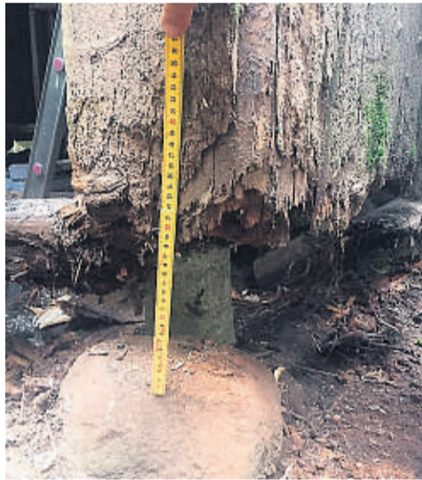
OPPSPIST: Oppspist hjørne som førte til at uthuset måtte løftes 20 cm opp for å få rettet opp bygget. Kun delene av tømmeret som var råtnet ble byttet ut.
