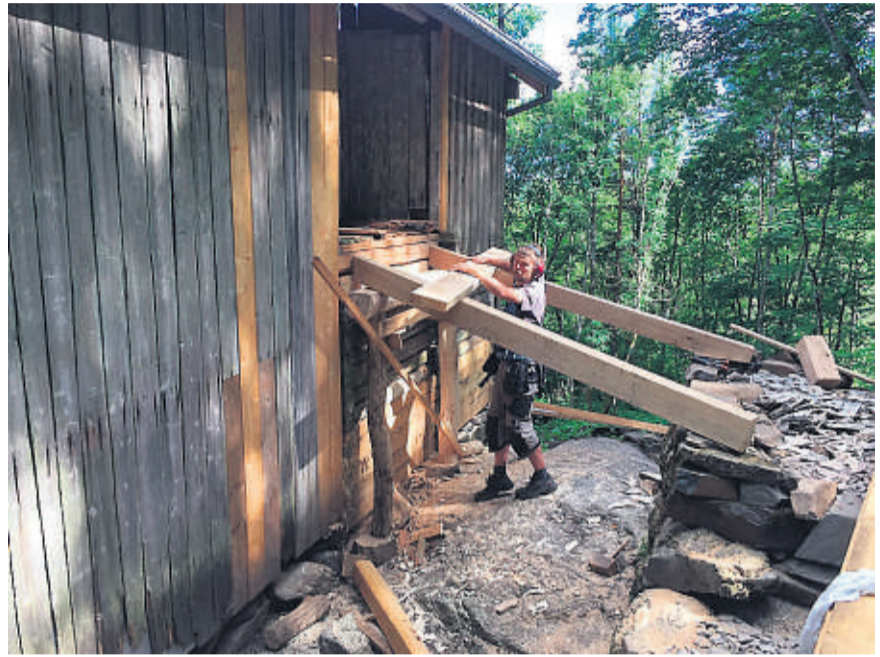
JULI 2017: Sollie Bygg i arbeid med ny låvebru. Foto: Privat
