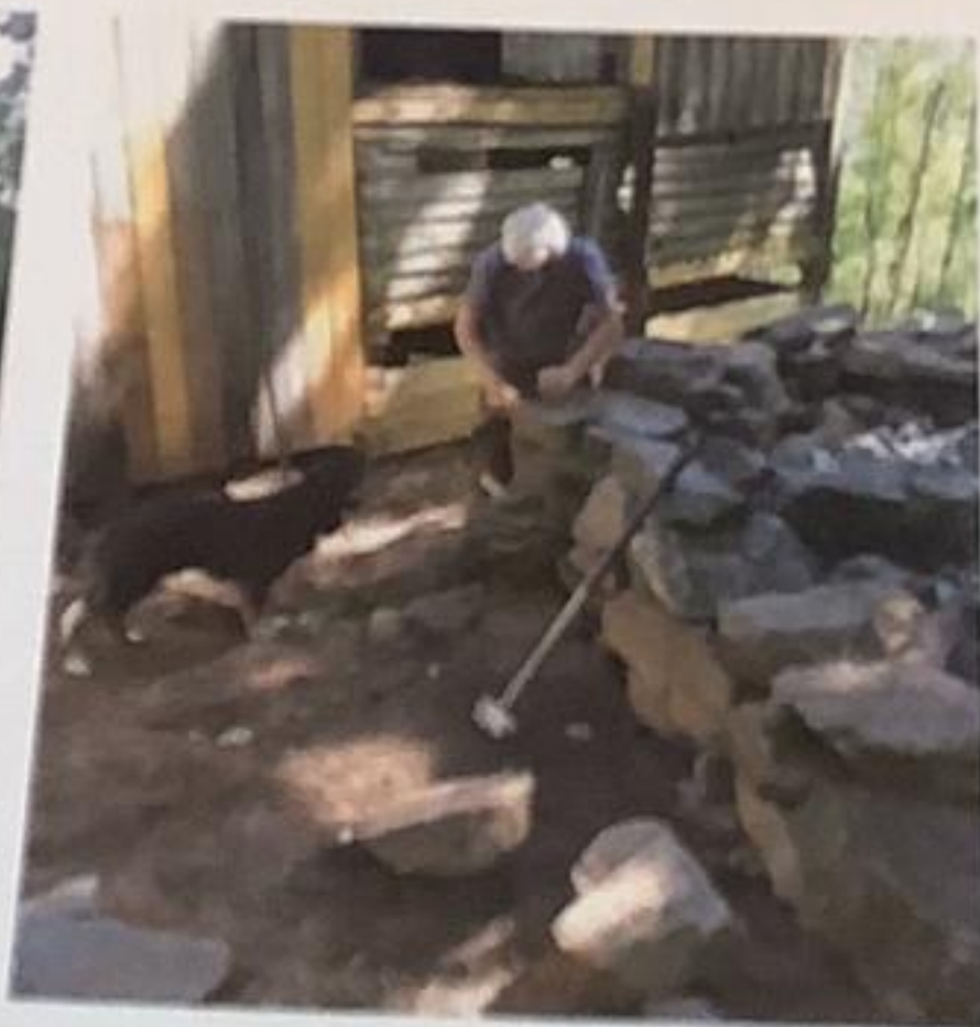
Eystein Greibrak og Ragg AS hjalp til med å mure opp fundamentet for låvebrua, som ble oppført av Sollie Bygg.
