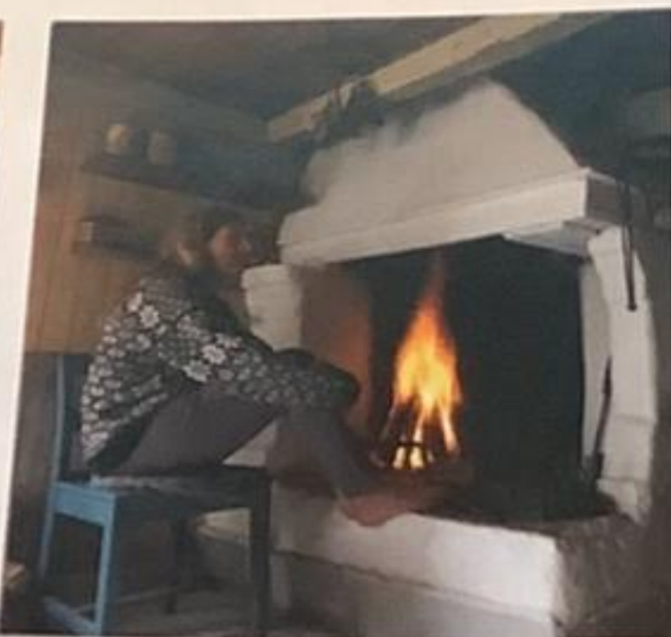
Nancy nyter varmen fra en ferdigmurt grue. Det ble benyttet tradisjonelle materialer til istandsettingen av grua, med puss laget av lokal leire, blandet med sand og vann
