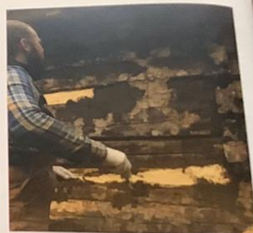
Under arbeidene fant man at veggene var isolert med kumøkk i hulrommene mellom tømmerstokkene. Her påfører Torgrim ny kumøkk før kledningen monteres.
