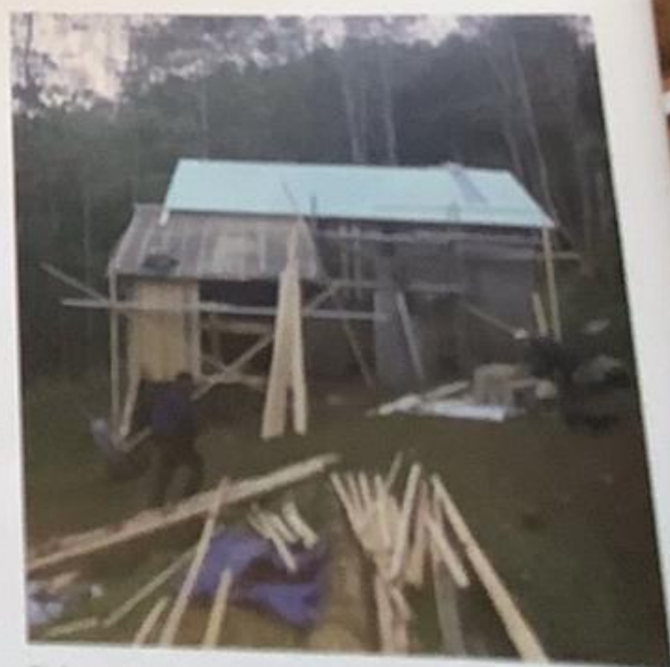
Taket på uthuset ble skiftet. Det ble lagt bølgeblekk fra samme produsent som den gamle.
