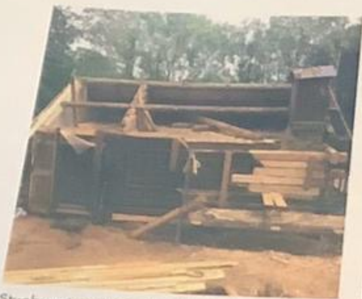
Stuebygningen, som hadde skader etter vannlekkasjer og stokkmaur, måtte utbedres.
