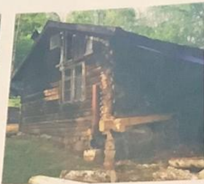
Istandsettingen har fulgt antikvariske prinsipper og det ble isolert med mose i laftefarene.
